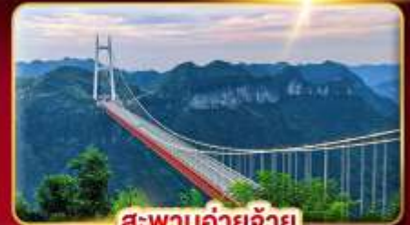
สะพานอ้ายจ้าย
