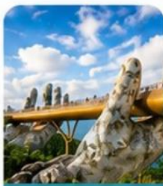
สะพานมือสีทอง
