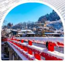
สะพานนากะบาชิ
