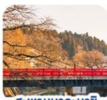
สะพานนากะบาชิ
